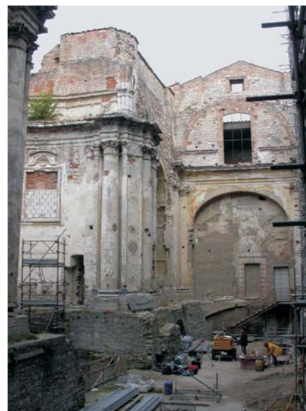
Figura 2 - Vista di una porzione dell'abside e del transetto
